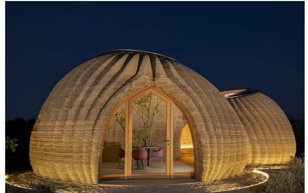
设计上，建筑师研究了建筑的形状和功能，以及建筑的材料组成如何有助于隔热和通风。形状和外部屋脊也使房屋结构保持平衡。里面是一个生活区、厨房和卧室，家具与建筑融为一体，其他独立的物体被设计为可回收或再利用。
